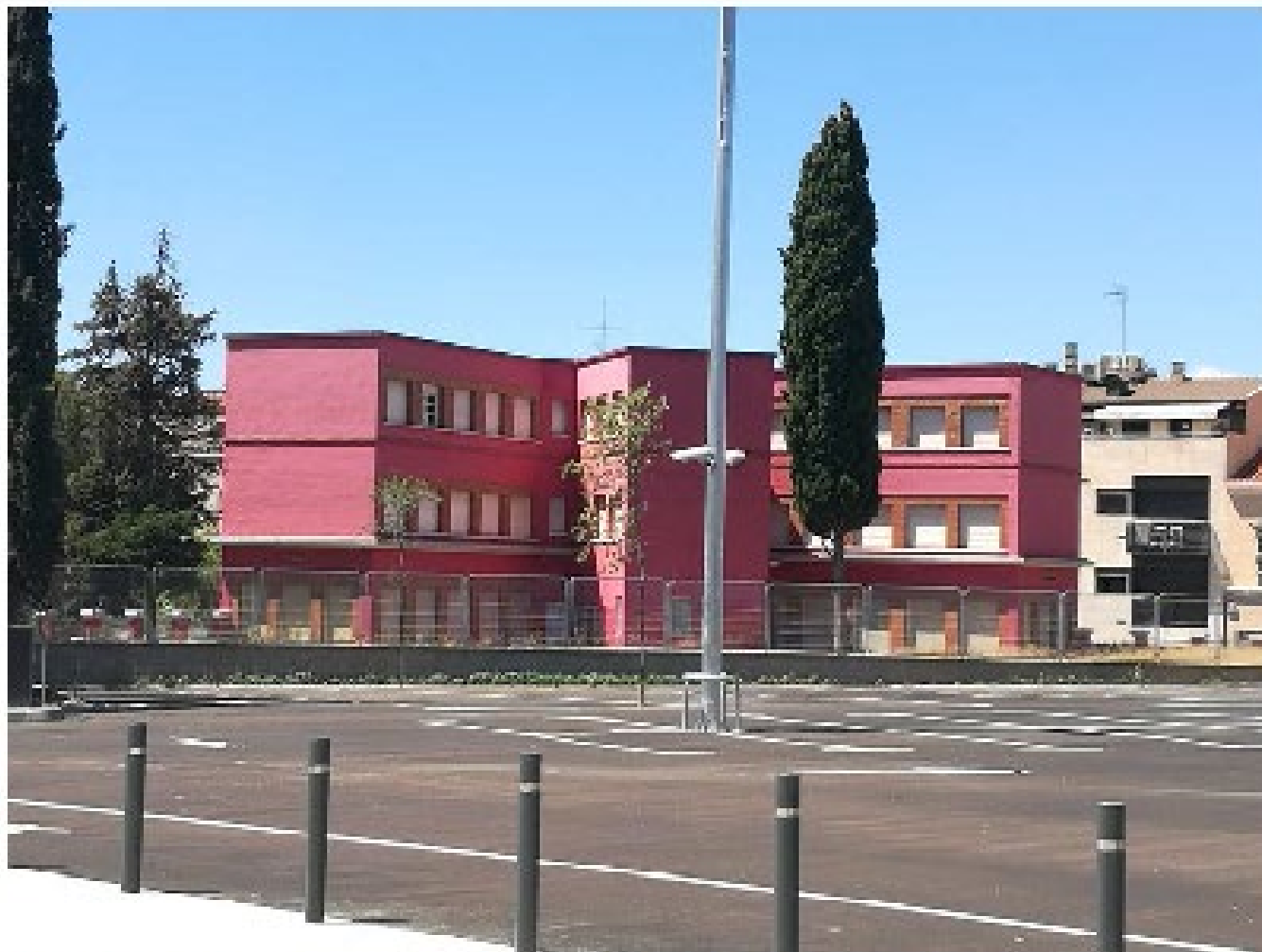
Foto 12: Façana Nord, interior de parcela. Autor: ROA Arquitectura
