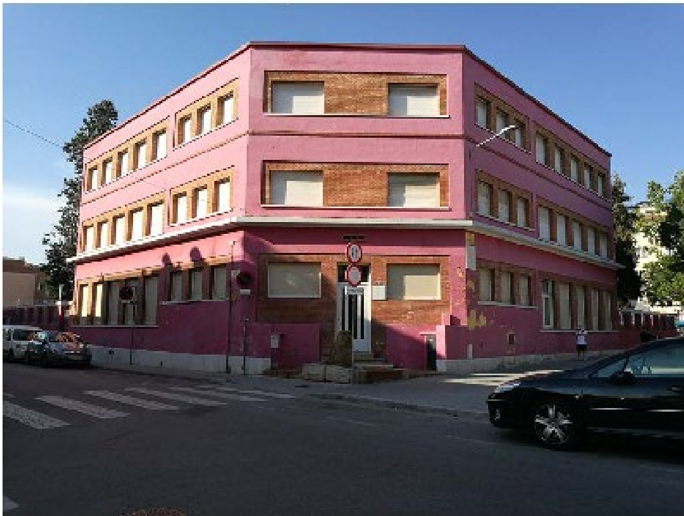
Foto 11: Façana plaça Jean piaget. Autor: ROA Arquitectura
